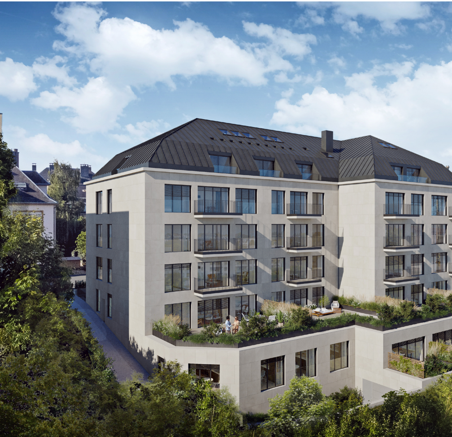
Vue façade arrière
