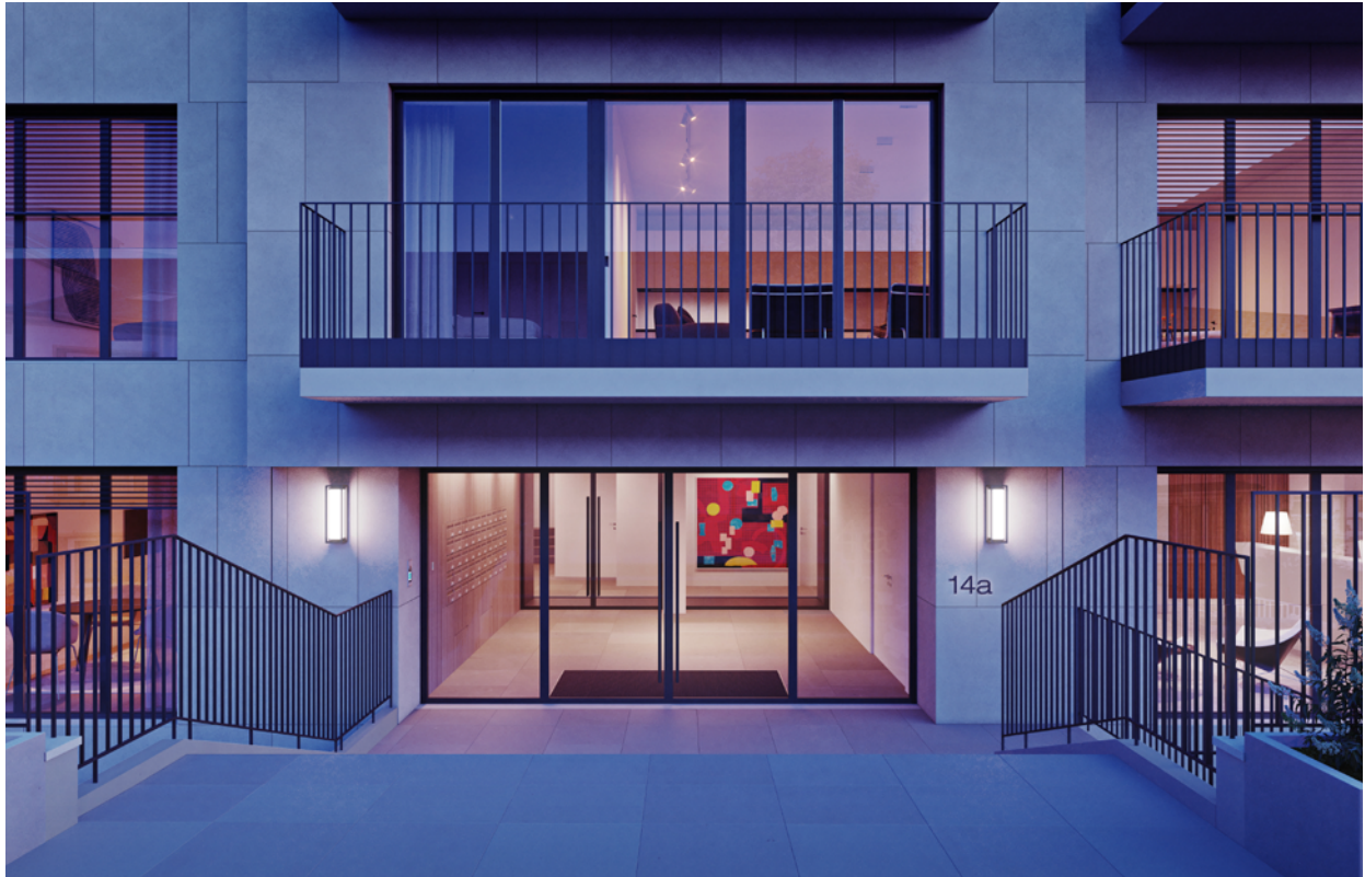
Entrée rue Jean-Pierre Brasseur
