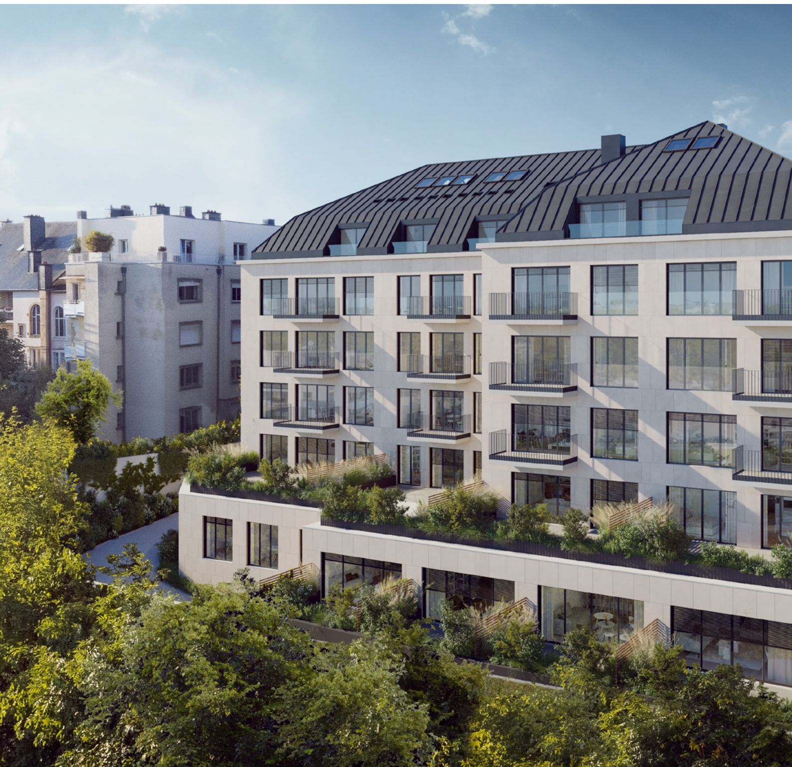
Vue façade arrière
